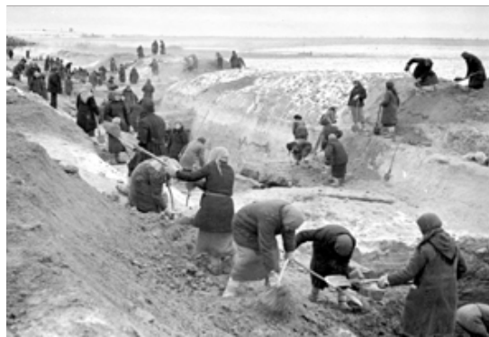
▲ Строительство оборонительных сооружений
